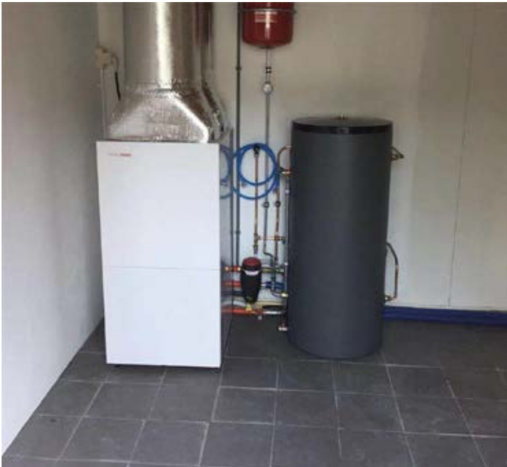
Figuur 2 Versi-I warmtepomp, 7 kW
