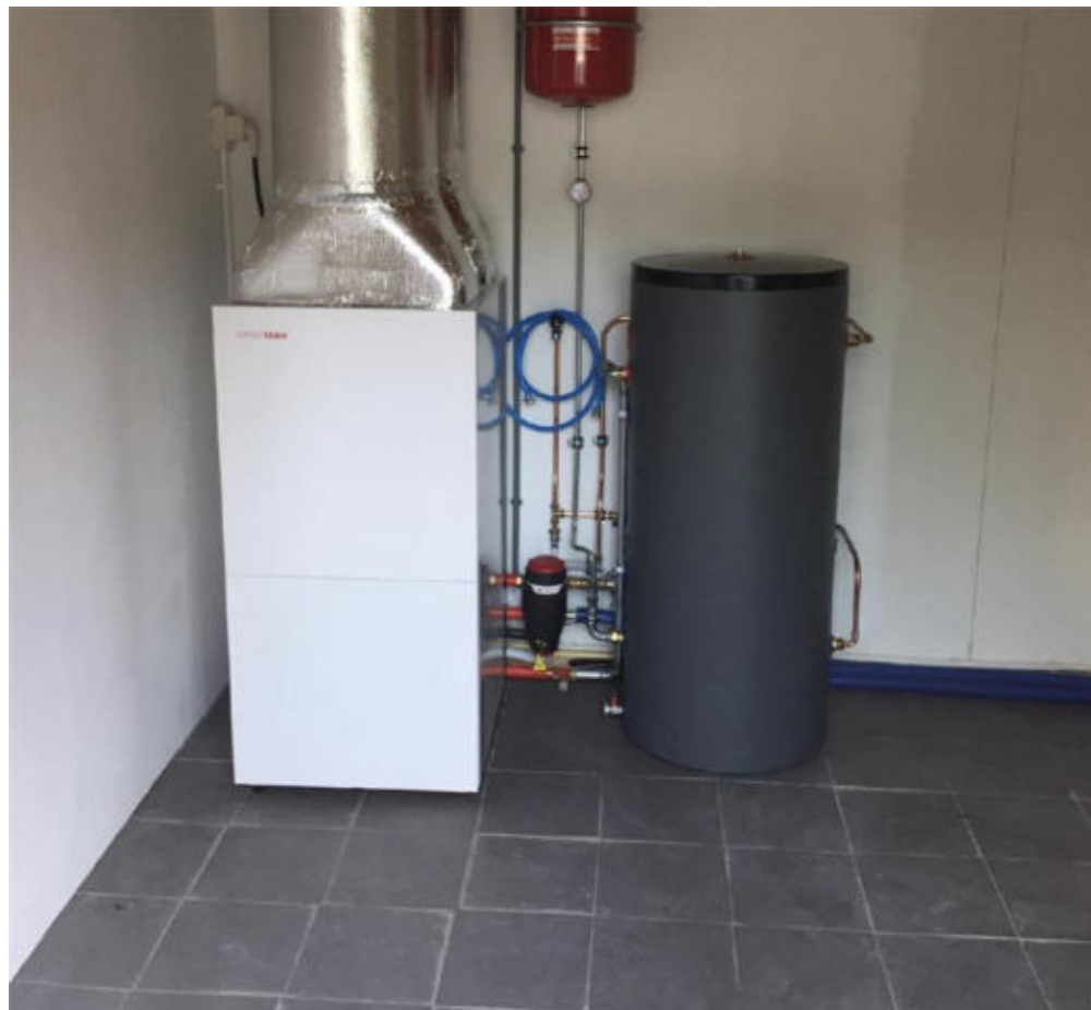
Figuur 2 Versi-I warmtepomp, 7 kW
